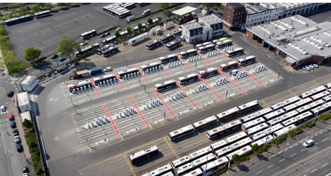
Luftbild mit Abstellflächen für Busse, teils mit E-Ladeinfrastruktur, Abfallsammelplatz sowie Werkstatt- und Verwaltungsgebäuden
